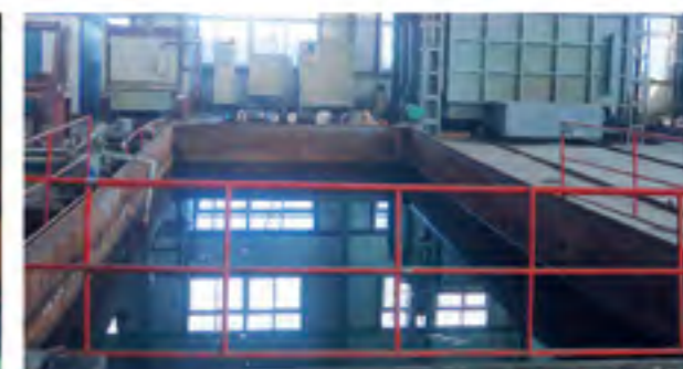
热处理炉 Thermal Treatment Furnace
